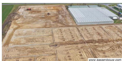
Voorbeeld bouwrijp maken voor kassenbouw
