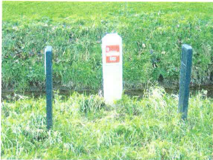
Paal kunststof bij brandput Totaal aantal: 8 stuks
