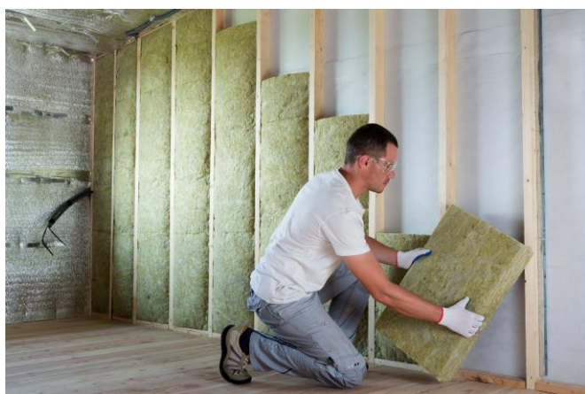
Figuur 15 - Aanbrengen van isolatiemateriaal
