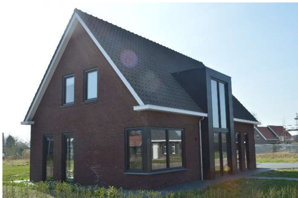
referentiebeeld doorbroken goot (bron: gemeente Borsele)
