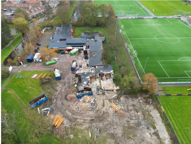
Afbeelding: circulaire sloop van de Mariaschool in Noord-Scharwoude waarvoor gemeente Dijk en Waard haar eerste certificaat circulair slopen heeft behaald.
