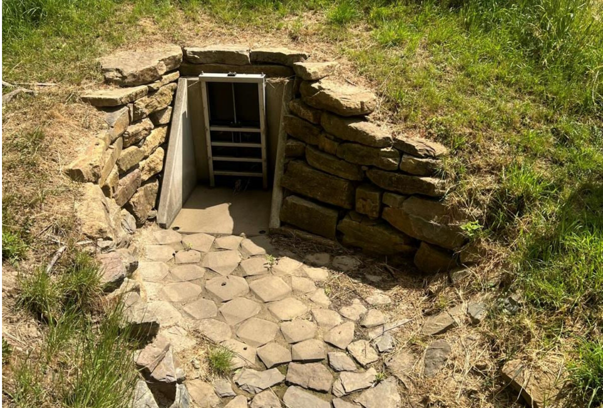
afbeelding 3: uitstroombak met afsluiter en uitstroomvoorziening
