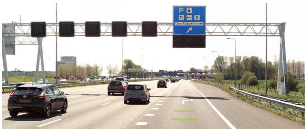
Situatie t.h.v. A4 hmp 14,35 Re
