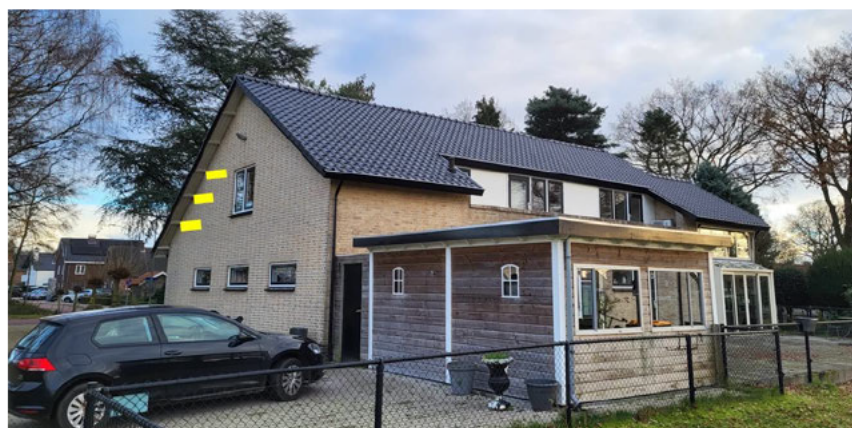
Figuur 7. Noordgevel woning Bisschopweg 45 met te plaatsen huismussenkasten (geel).
