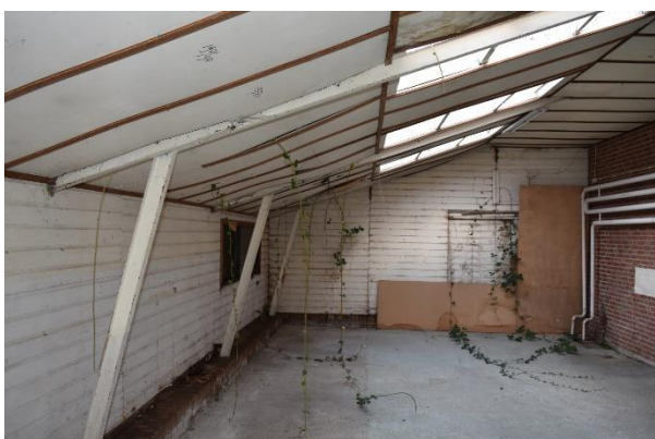
De constructie van de kweekkas uit 1960 (links). Boven de bakstenen plint zijn de gevelwanden en het lessenaardak geheel vernieuwd. Het schoollokaal op de eerste verdieping (rechts), voorzien van een schuifwand.
