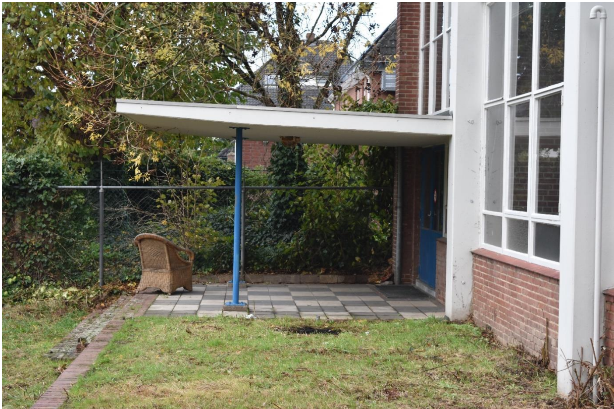
De slanke luifel aan de zuidoostgevel, de entree vanaf de binnenterreinen. Op de voorgrond het ommuurde plantenperk.
