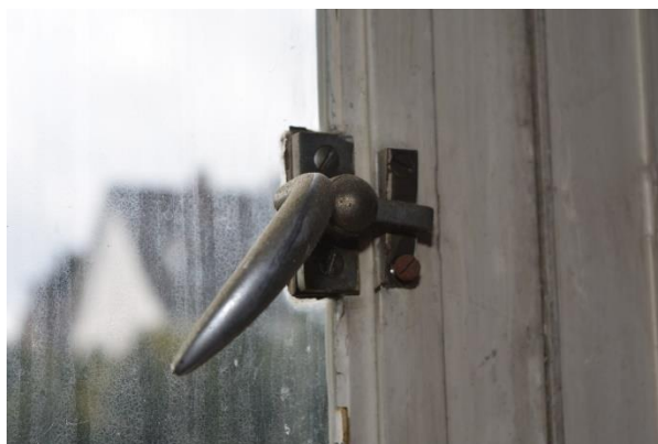
Detail van een stalen venster in de achter- of zuidoostgevel (links) en raamsluiting van een stalen venster (rechts). Deze vensters zijn origineel.
