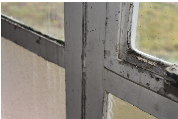
Detail van een stalen venster in de achter- of zuidoostgevel (links) en raamsluiting van een stalen venster (rechts). Deze vensters zijn origineel.
