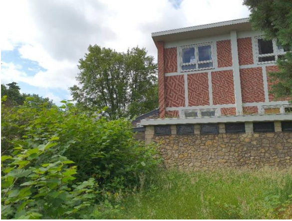
FB16: Impressie van hetvoerdeel achterbhet pand. Volledig begroeid. Inspectie van het maaiveld is zeer beperkt.
