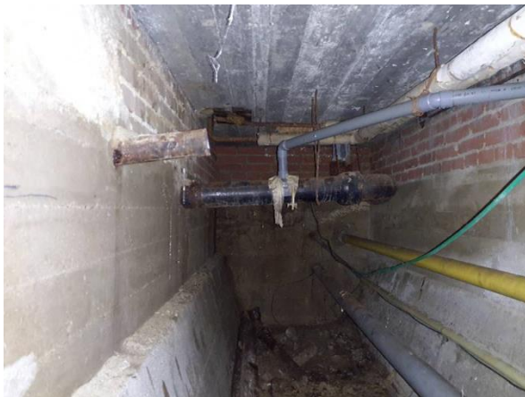
FB05: Impressie van de riolering, zichtbaar in de kruipruimte. Bestaat uit gietijzer. Niet asbestverdacht.
