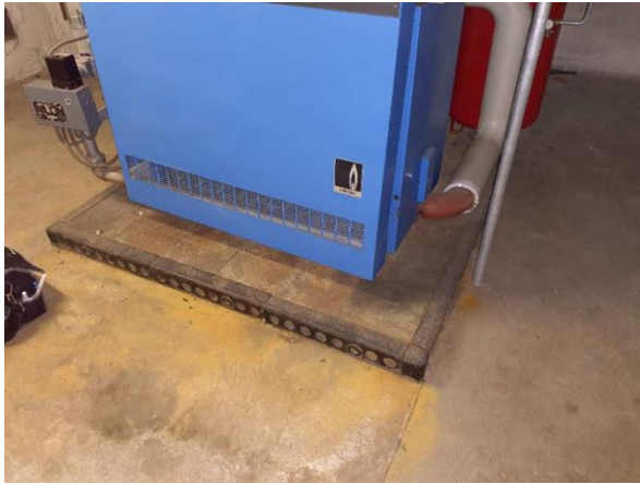
FB04: Impressie van de opstort onder de Cv-installatie. Niet asbestverdacht.
