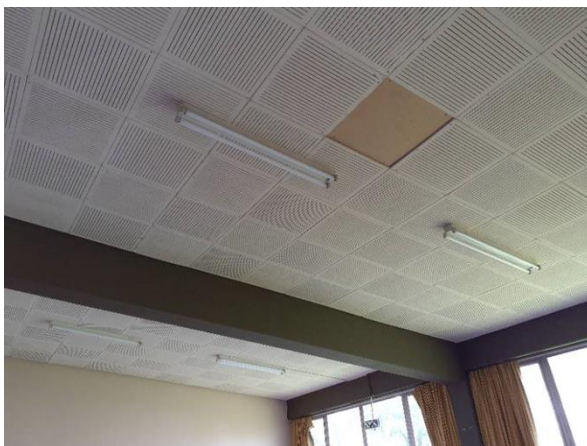
FB09: Impressie van het plafond, 1e verdieping. Hierboven is geen destructief onderzoek uitgevoerd.
