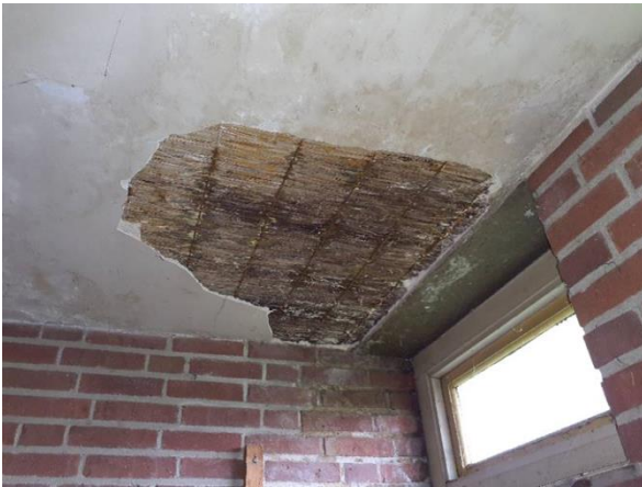
FB17: Impressie van het plafond, niet asbestverdacht.
