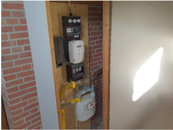
FB07: Impressie van de meterkast. Geen asbestverdachte toepassingen aangetroffen.
