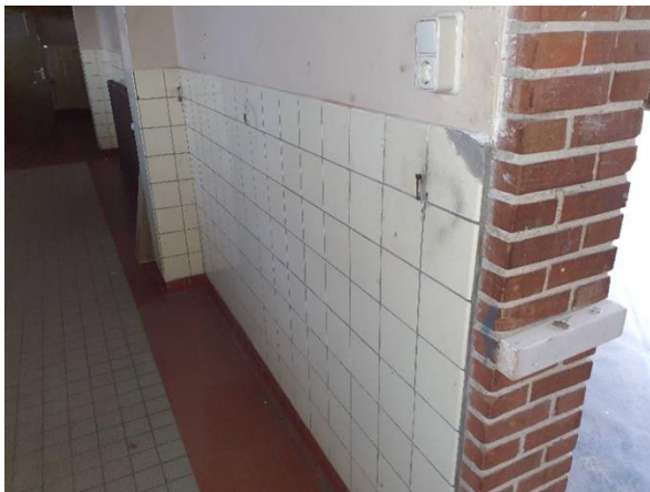
FB20: Impressie van de keramische wandtegels. De tegels zijn aangebracht in de specie, niet asbestverdacht.
