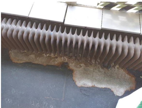
FB12: Impressie van de vloer op de 1e verdieping. Het zeil is niet verdacht. Hieronder is geen asbestverdachte toepassing aangetroffen.
