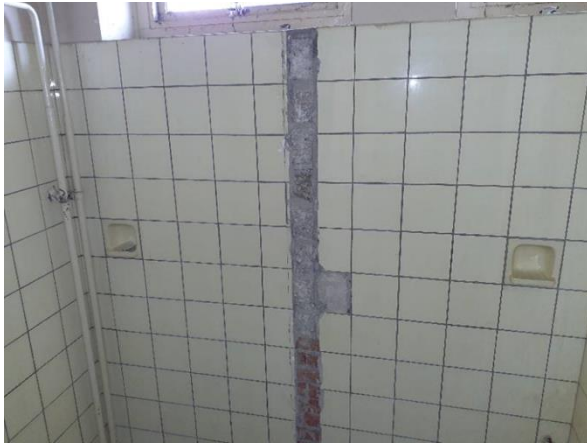
FB19: Impressie van de keramische wandtegels. De tegels zijn aangebracht in de specie, niet asbestverdacht.
