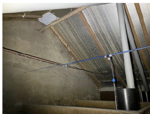
Figuur 6. Binnenzijde stal met isolatieplaten tegen het dak.
