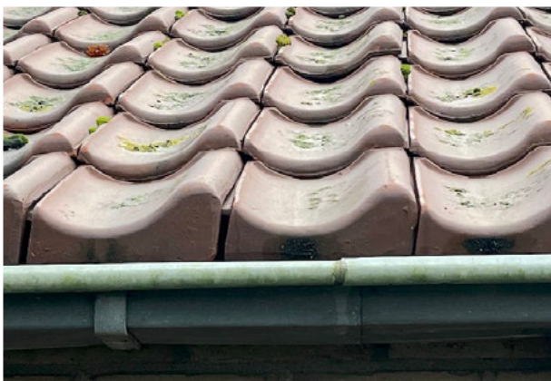
Figuur 1. Dakrand bijgebouw met kappannen.
