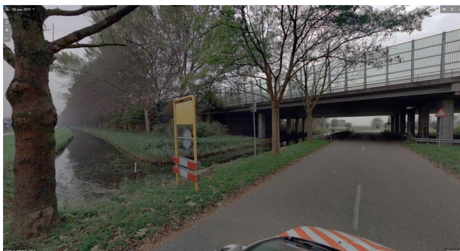
Figuur 3.3: De watergang onder de A9, parallel aan de Polderweg – Foto genomen ten noorden van het viaduct, kijkend in zuidelijke richting (bron: Streetsmart, Cyclomedia ©)
