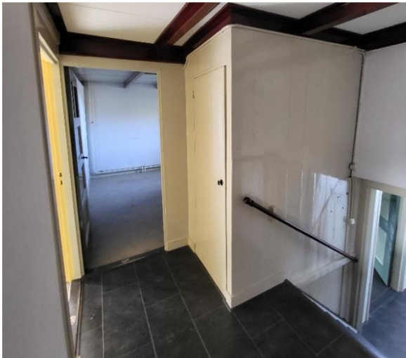
Kast op overloop met in betimmering zichtbaar overgang tussen betimmering rondom trap van bel-etage naar verdieping en later aangebrachte betimmering kast op verdieping.
