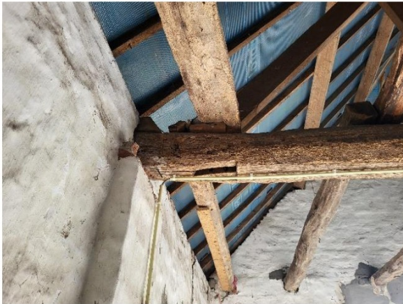
Pengat voor korbeel bij vierde ankerbalk gezien vanaf de achtergevel.
