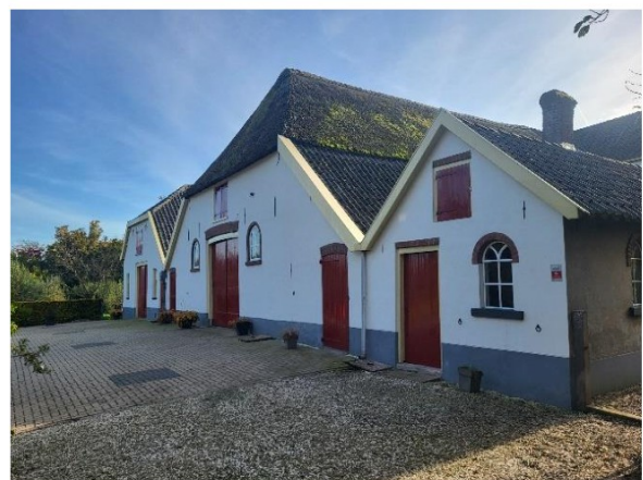
Overzichtsfoto van de achtergevel gezien vanuit het westen.
