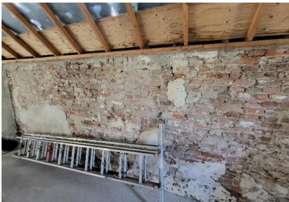
bouwsporen van een venster in de scheidingswand tussen de deel en fruitschuur.
