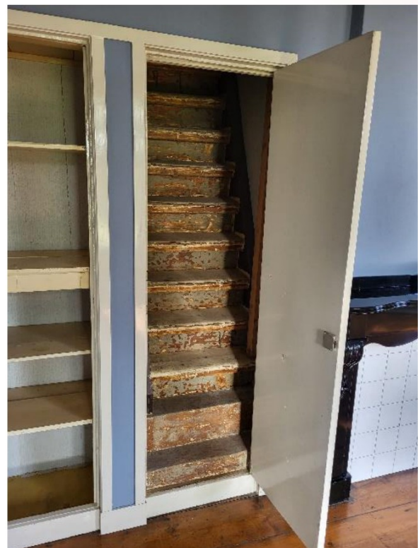
Trap en kast links van de schouw, het trapgat is aan de bovenzijde gedicht.
