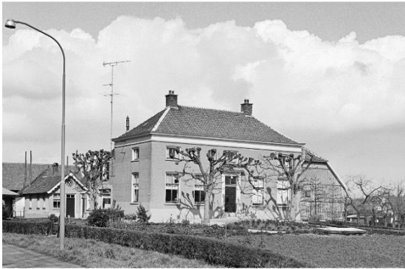
Steurenborg gezien vanuit het zuiden (1977) Beeldbank RCE documentnr. 184.568
