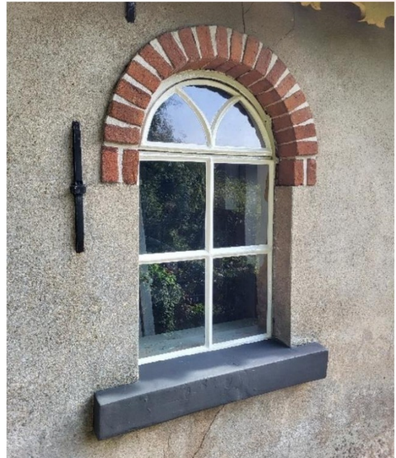
Rondboog venster in de westgevel van het bakhuisje met kiepend bovenlicht.
