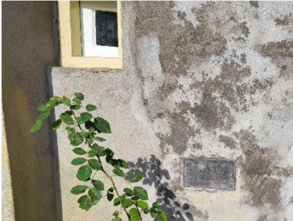
Gevelsteen met de tekst CLARA 1893 en het toiletraam links in de gevel.
