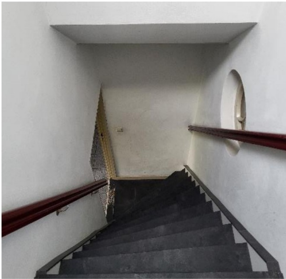
Trap richting de verdieping vanuit de keuken.
