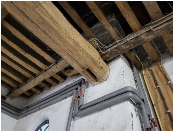
Oplegging van de ankerbalk in de metselwerkwand naar de keuken met een pengat voor de aansluiting van een korbeel.
