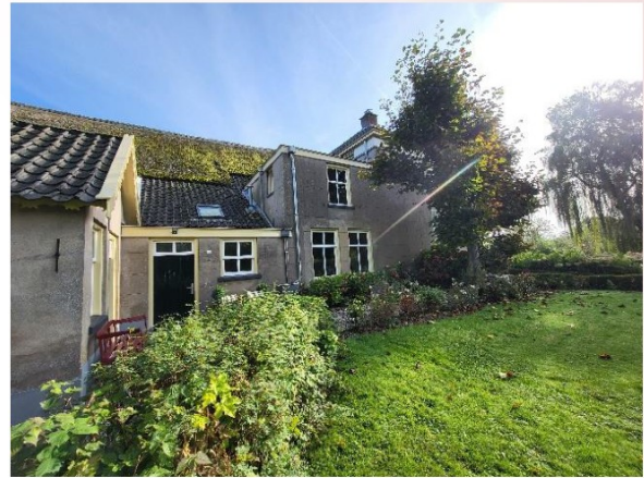
Overzichtsfoto linker zijgevel (westgevel) met gevel van keuken en slaapkamer (twee bouwlagen) de voormalige bijkeuken. (een bouwlaag)
