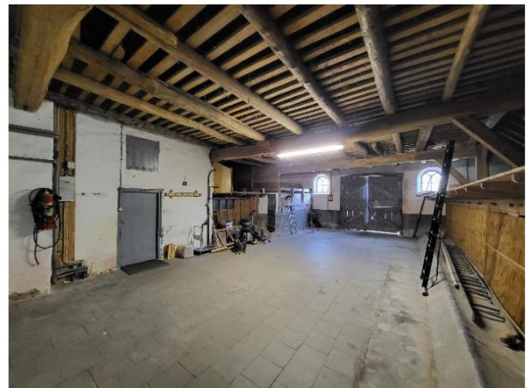
Interieur deel gezien richting de achtergevel met links de deur richting de vm. bijkeuken nu keuken.
