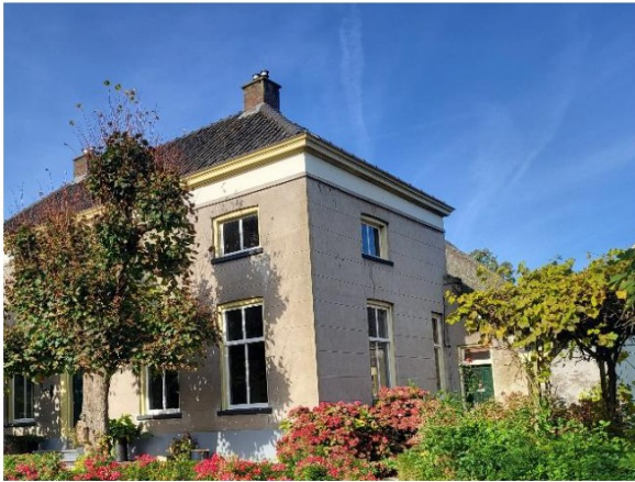
Overzichtsfoto rechter zijgevel voorhuis (oostgevel)
