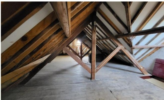
Kapconstructie met enkelvoudige hangwerk spanten.
