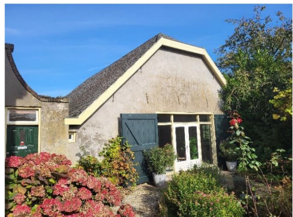
Overzichtsfoto zuidgevel van de schuur
