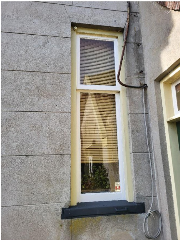
afwijkend schuifvenster in de rechter zijgevel. (oostgevel)
