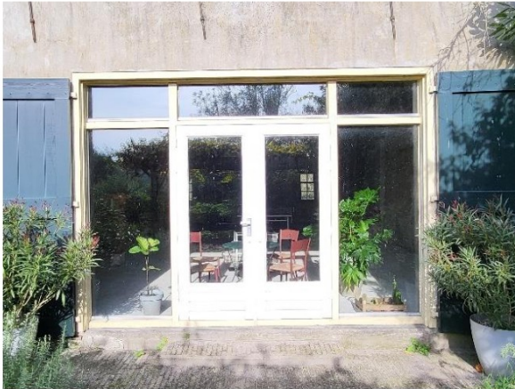
Pui van kozijnen met standaard maten voorzien van dubbelglas.
