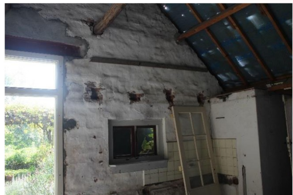
bouwsporen van voormalige afgesloten pantry aan de zuidgevel, ook zichtbaar is de stalen latei boven de nieuwe pui in de zuidgevel.
