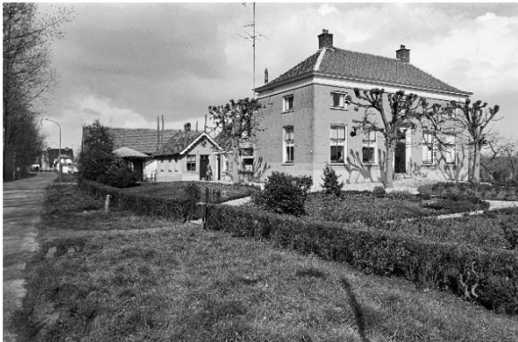
Steurenborg gezien vanuit het zuiden (1977) Beeldbank RCE documentnr. 184.570
