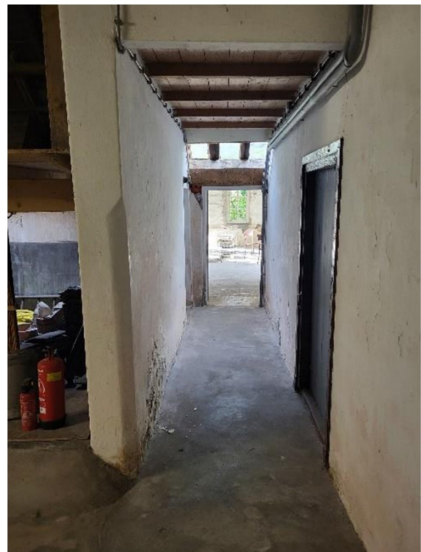
Gang in de oostelijke zijbeuk van de deel langs de koestallen richting de (fruit)schuur. De deur rechts geeft toegang tot de kelder onder het voorhuis.
