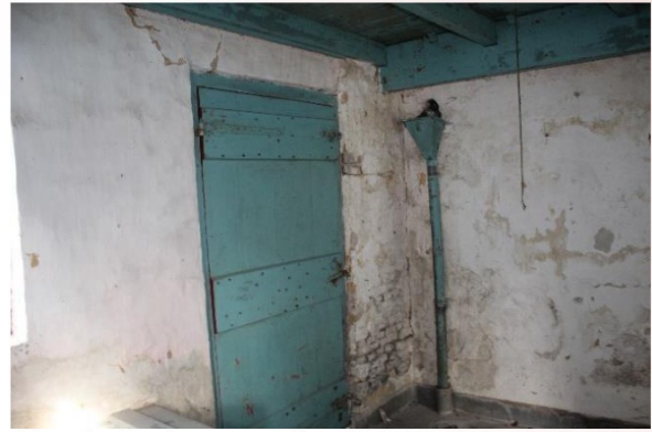
Hemelwaterafvoer van zakgoot tussen deel en bakhuisje.
