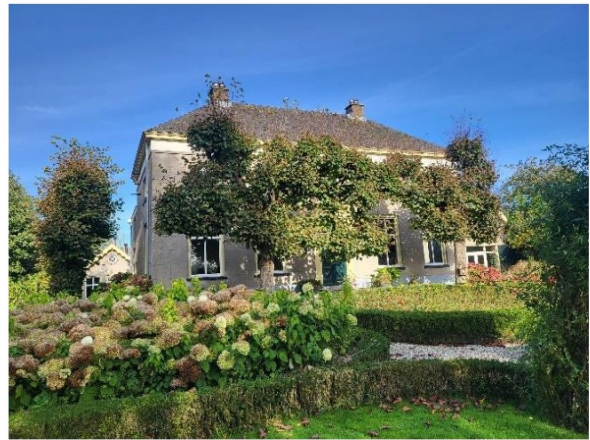
overzichtsfoto voorgevel (zuidgevel).
