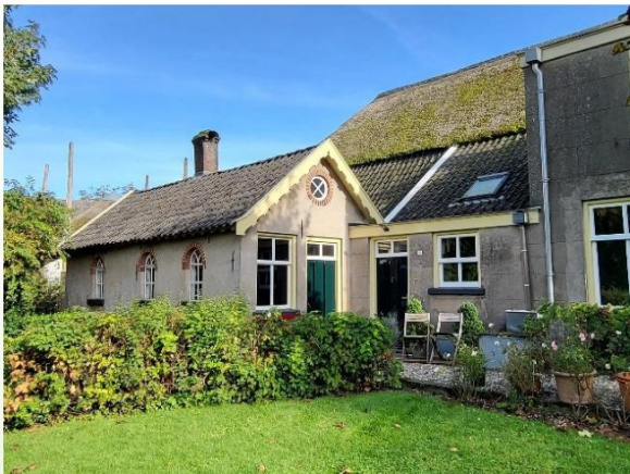
Overzichtsfoto van het bakhuisje gezien vanuit het zuiden.
