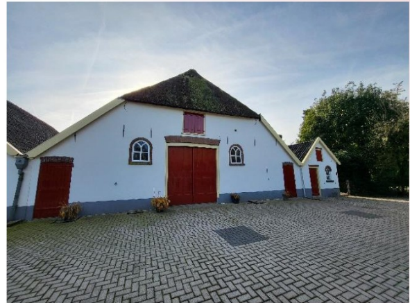
Overzichtsfoto noordgevel deel/achterhuis.
