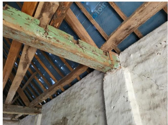
Oplegging voormalige moerbalk op metselwerk penant.
