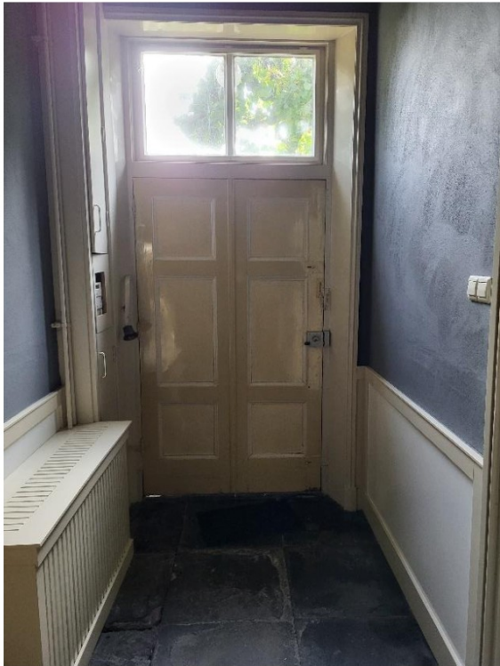
Het bovenlicht van de voordeur is voorzien van achterzetbeglazing. Aan de onderzijde van de deur kan buitenlucht binnen stromen. De radiator in de entree is omtimmerd, dit hindert de luchtstroom van langs de radiator.
