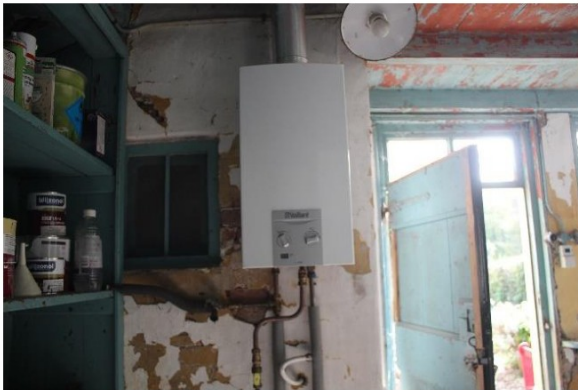
Voormalige gevel van het toilet met venster, in het pleisterwerk zijn sporen van imitatievoegen zichtbaar
