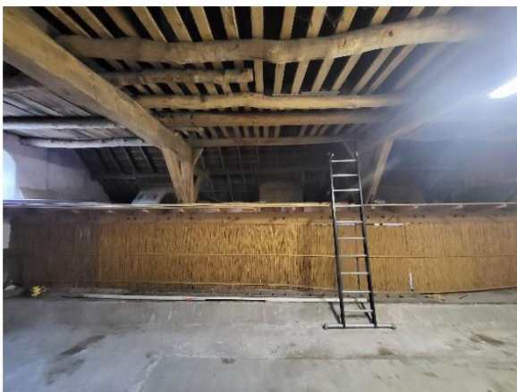
De koestallen gezien vanuit de middenbeuk. Links is de gesloten zoldervloer in het vak aan de achteregevel zichtbaar
