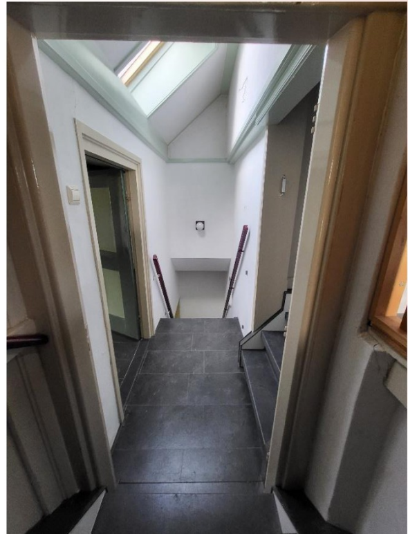
verkeersruimte op de verdieping gezien vanuit het voorhuis met rechts de doorgang naar de bergruimte door de voormalige brandmuur.
