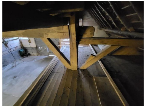
Fragment van ankerbalk gebint aan de zijde van de achtergevel, de onderdelen van dit ankerbalkgebint zijn gemerkt met een enkel gaatje.
