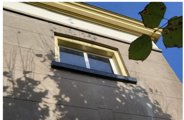
Schuifvenster ter hoogte van de verdieping
