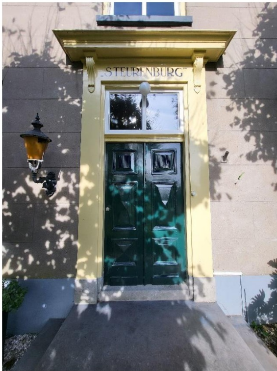
entree centraal in de voorgevel.
