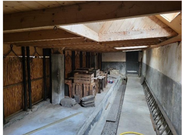
De gebintstijlen zijn ter plaatse van de voormalige koestallen ingekort en staan op betonnen poeren
