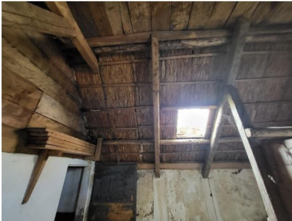
Het dak is ter plaatse van de paardenstal met pannen gedekt. Tussen de sporen is riet aangebracht, waarschijnlijk ter isolatie.
