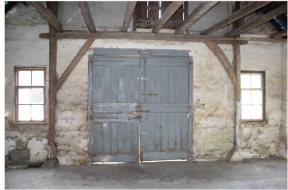
Ankerbalkgebint langs de achtergevel.
