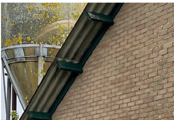
Figuur 3. Dakrand kopgevel stal.
