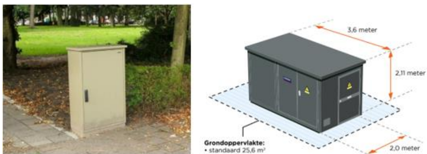
Figuur 1 Voorbeeld van een buitenkast voor laagspanning (l) en afmetingen van een compact station voor middenspanning (r)
