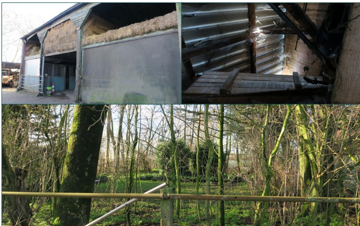
Figuur 3.3 Linksboven: de hooizolder (12). Rechtsboven: de zolder in het zomerhuis (4). Beneden: gedeelte van het groen op de planlocatie naast schapenstal (14).
