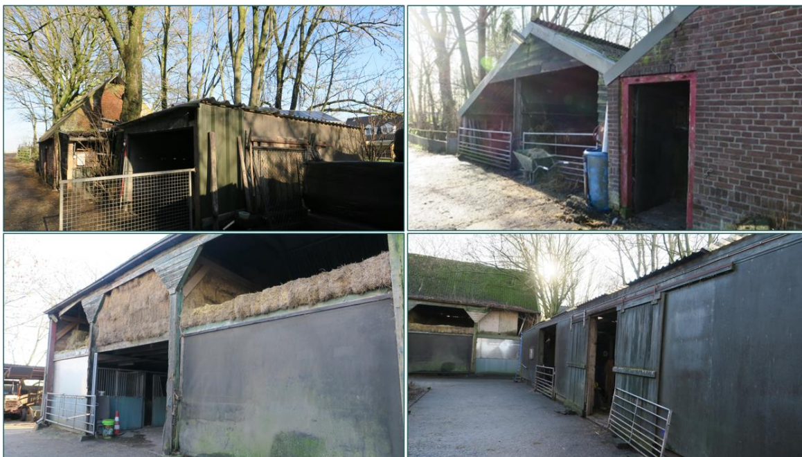
Figuur 1.3 Linksboven betreft de te slopen garage (6) met daarachter de te renoveren berging (5) en zomerhuis (4). Rechtsboven betreft de schapenstal (14) en de schapenstal/berging (13), welke beide deels worden gesloopt deels worden gerenoveerd/gewijzigd. Linksonder betreft de paardenstal (12) welke eveneens deels wordt gesloopt en deels wordt gewijzigd. Rechtsonder betreft te de slopen paarden/schapenstal (17).
