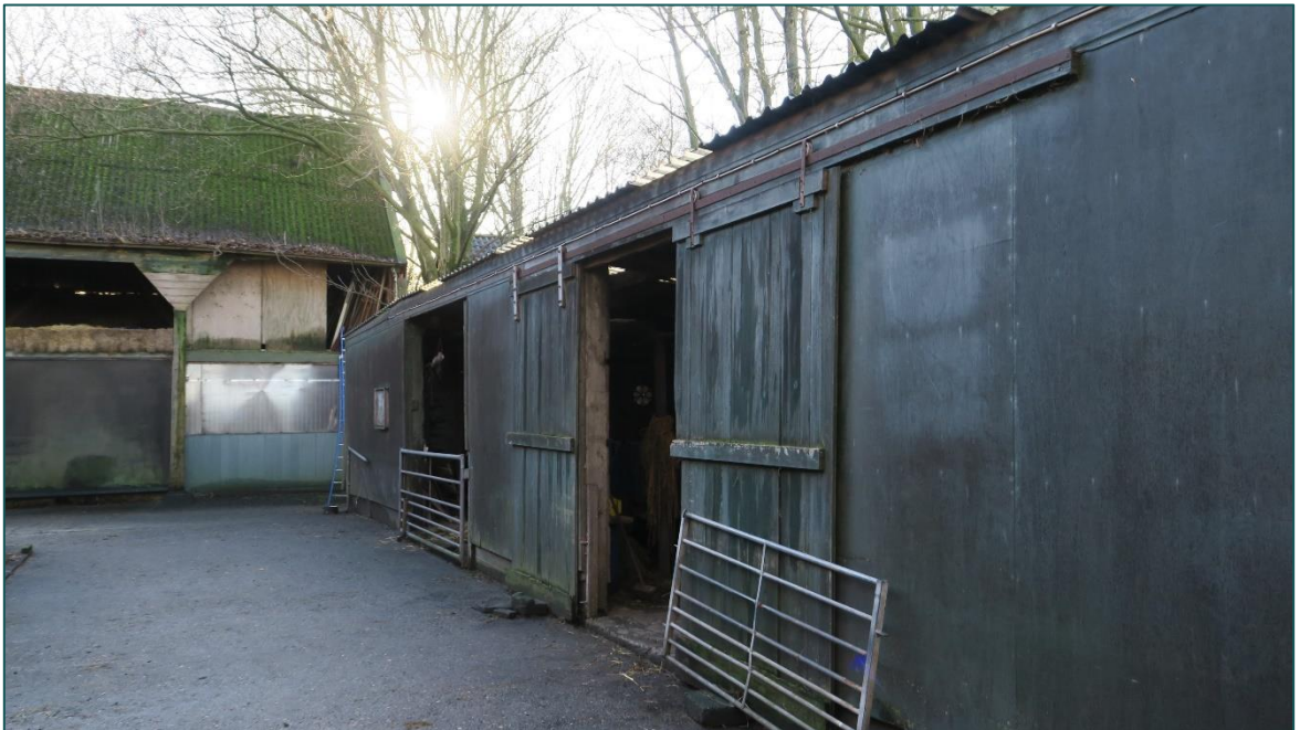
Figuur 6 De paardenstal/schapenstal (17) en deel van paardenstal (12).
