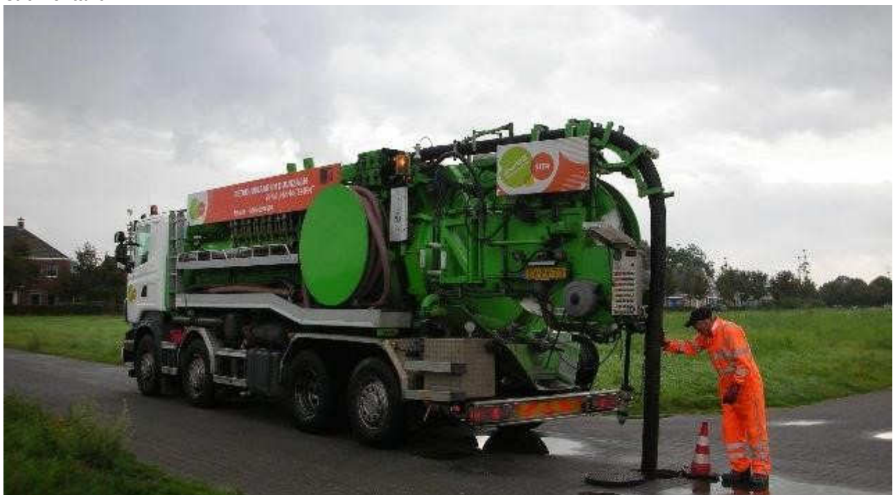
Figuur 15 Rioolinspectie (bron: archief werkorganisatie Langedijk en Heerhugowaard, 2014)
