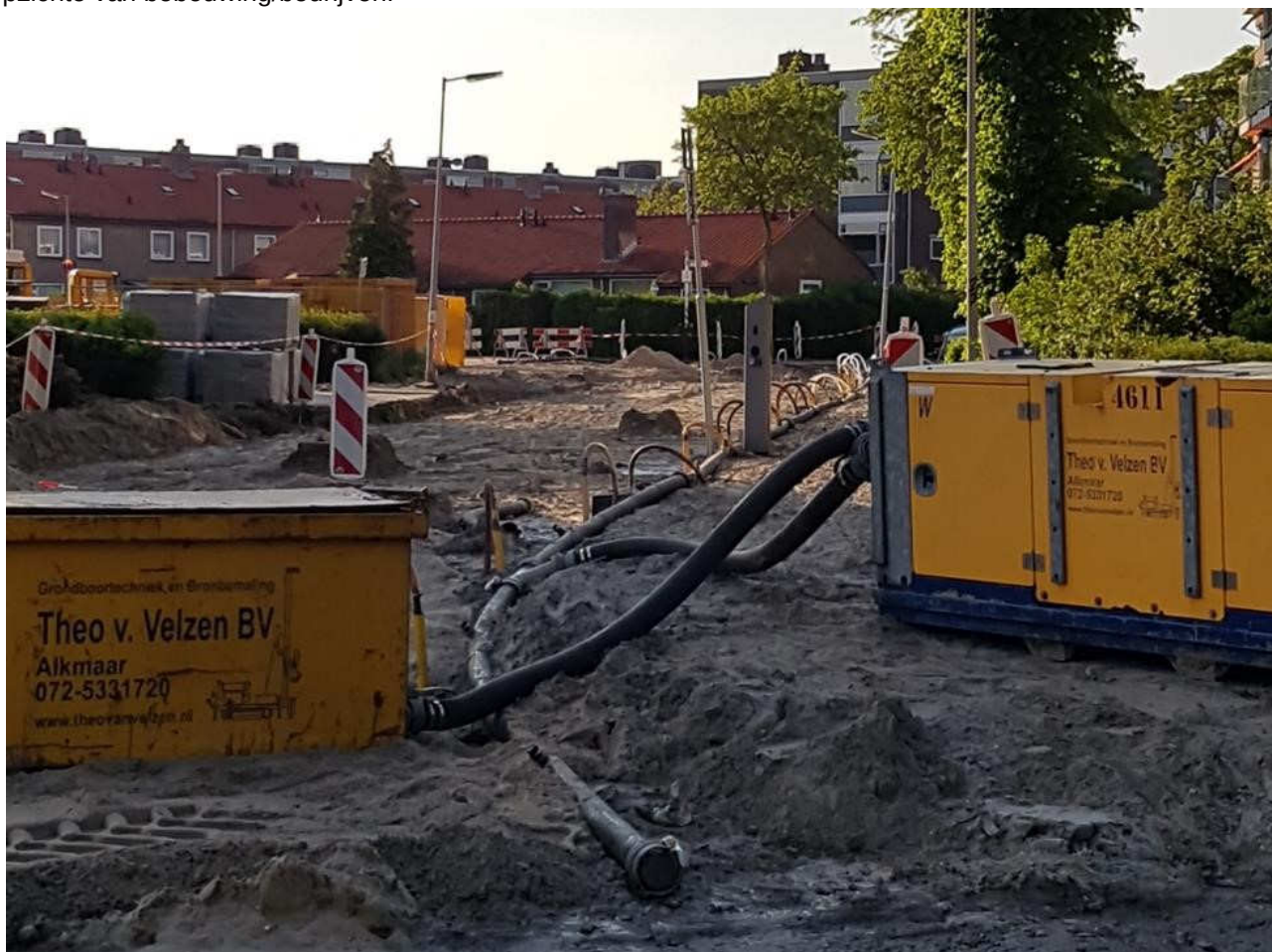
Figuur 14 Rioolwerkzaamheden Alkmaar Overdie (Bron: T. Dekker)
