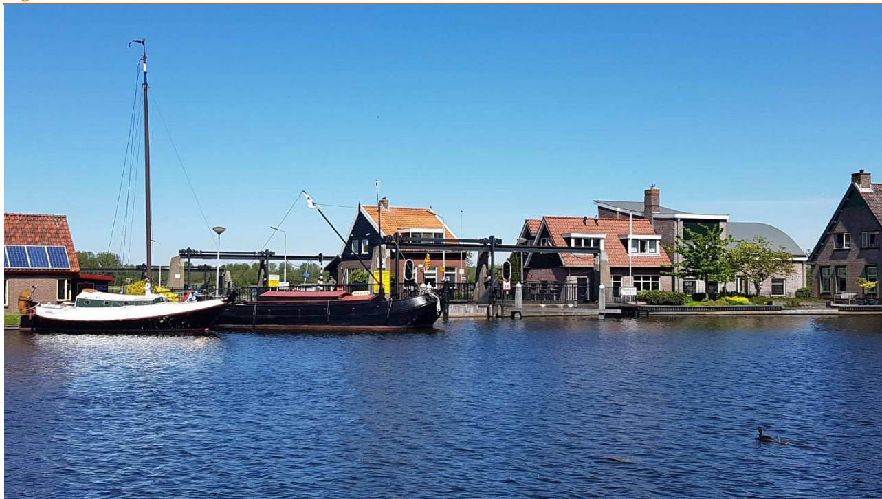
Figuur 13 Sluis Broek op Langedijk (Bron: T. Dekker)
