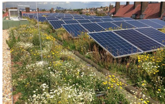
voorbeeld groen dak met zonnepanelen
