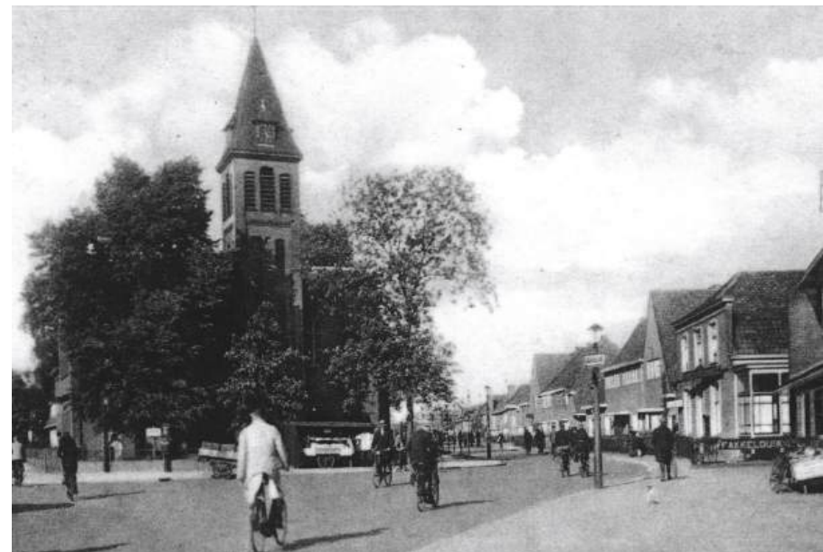
Knooppunt Larensseweg-Eemnesserweg met op de achtergrond de voormalige kerk (SAGV)
