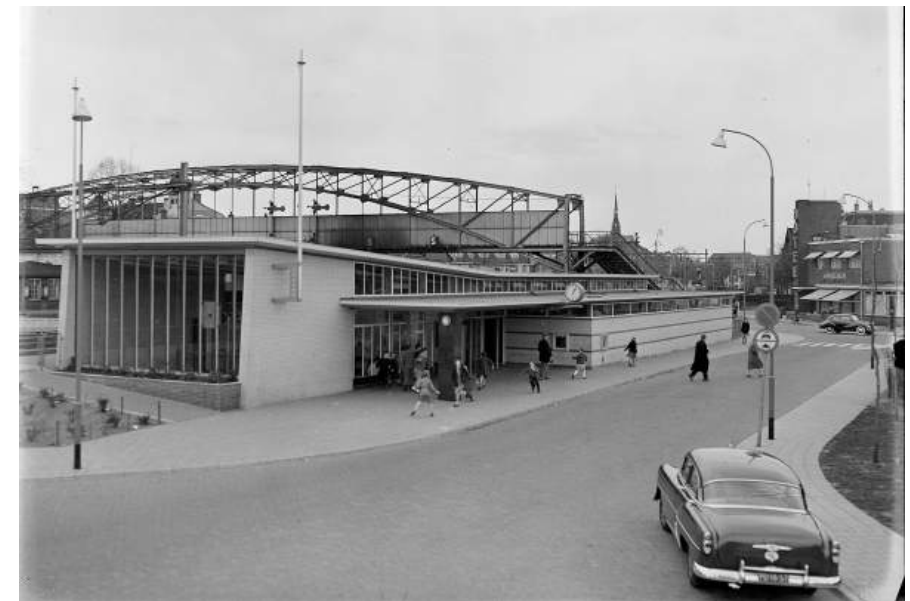
Stationsgebouwtje oostzijde (SAGV)
