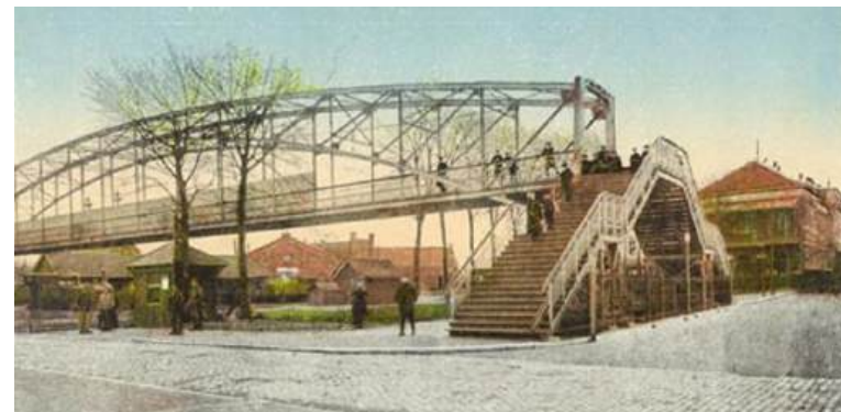
Omdat Hilversum zich ook aan de oostzijde van het spoor sterk uitbreidde, werd in 1910 een voetbrug aangelegd (SAGV)
