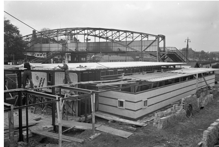
Het oostelijke ingangsgebouw in aanbouw, 1954. Op de achtergrond de voetgangersbrug die na het gereedkomen van de perrontunnel werd afgebroken (foto W.P.F.M. van Schaik, HUA)
