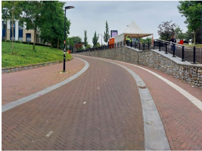
Voorbeeld toegankelijkheid. Geleidelijnen zijn mee-ontworpen. (Station Driebergen-Zeist)
