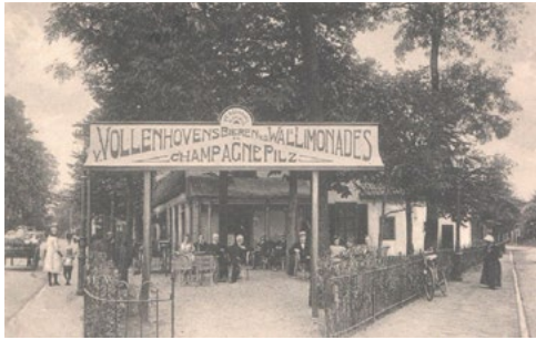
Laag 2: Terras van de Uitspanning aan de Larenseweg 2
