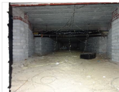
Figuur 2.14 Kruipruimte onder het gebouw.
