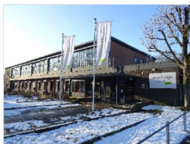
Figuur 2.3 Entree schoolgebouw de Aventurijn en voorgevel aan zuidoost zijde.
