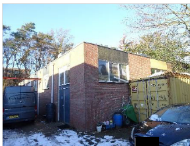
Figuur 2.13 Bijgebouw aan noordzijde van het terrein.
