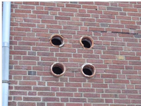
Figuur 4.6 Openingen in de muur van zuidwestgevel.
