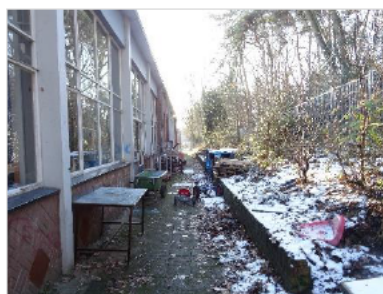
Figuur 2.7 Pad langs achterzijde van het terrein met noordwestgevel.
