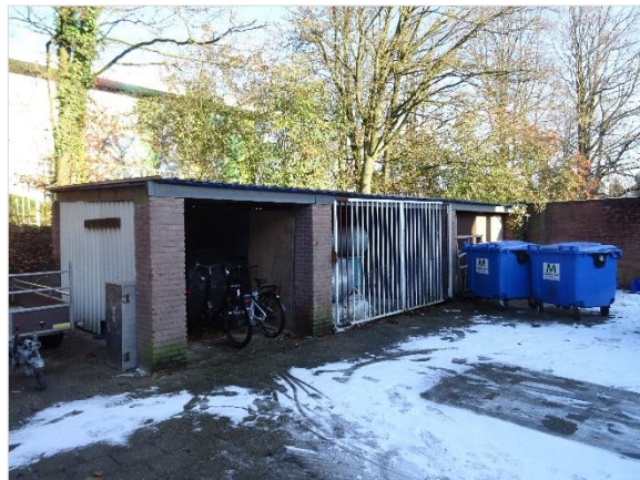
Figuur 4.10 Schuurtje met dichtgetimmerde ruimtes geschikt voor steenmarter
