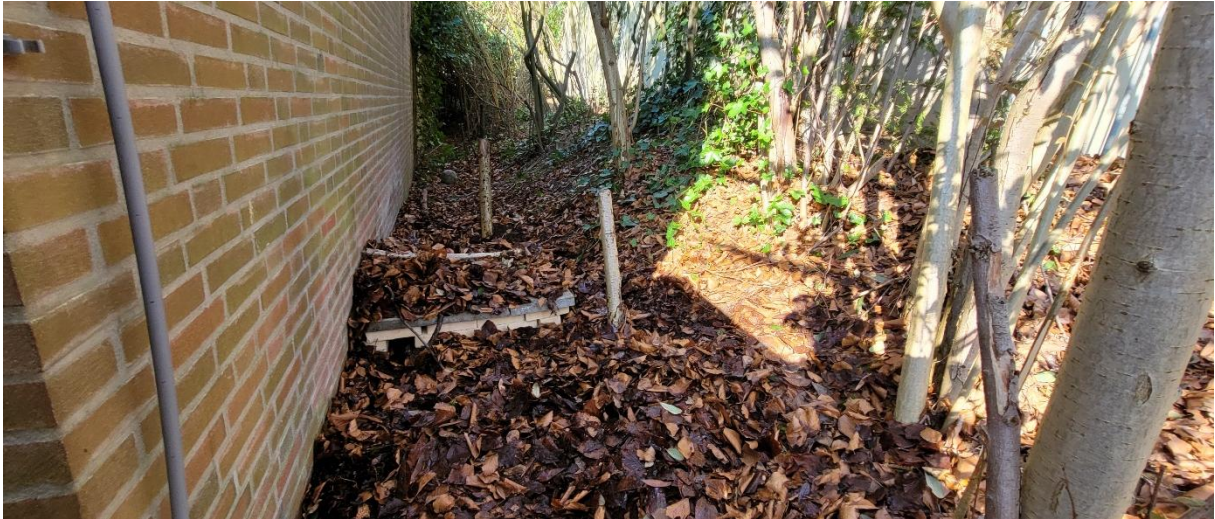
Figuur 4. Steenmarterverblijf oost
