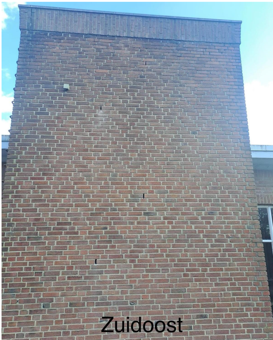
Figuur 1 Zuidoost zijde met open stootvoegen.
