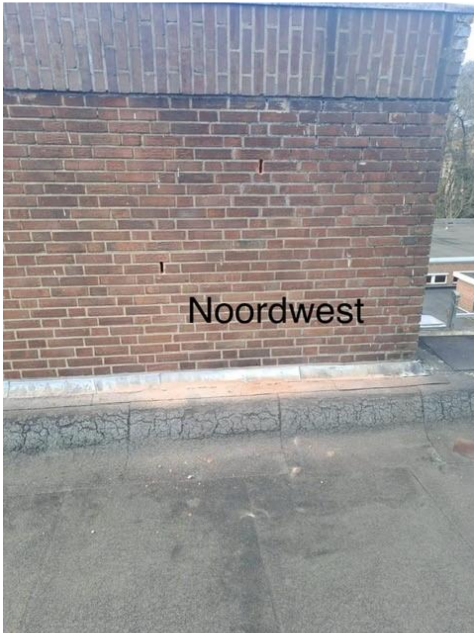
Figuur 2. Noordwest zijde met open stootvoegen
