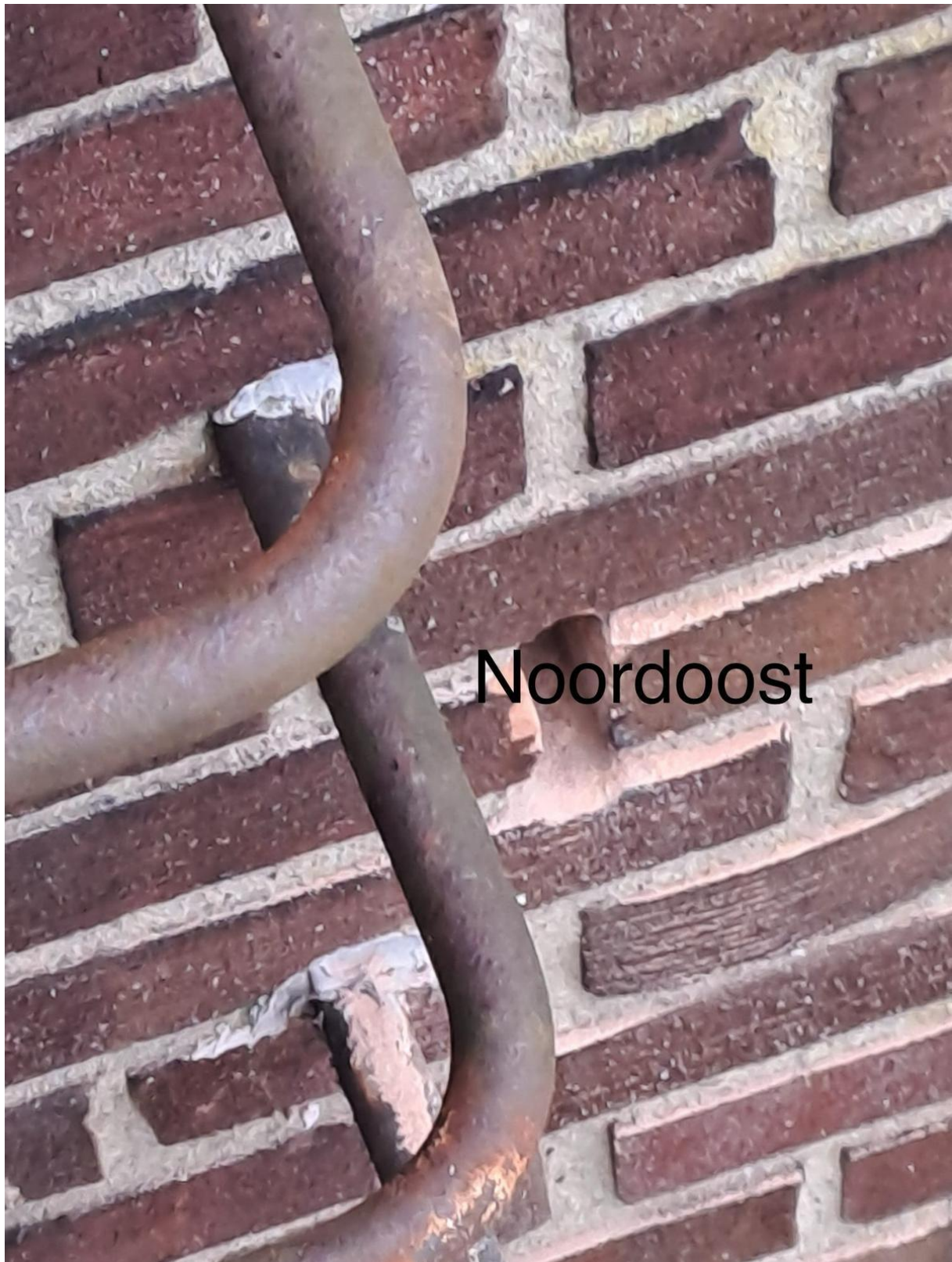
Figuur 3. Noordoost zijde met open stootvoegen
