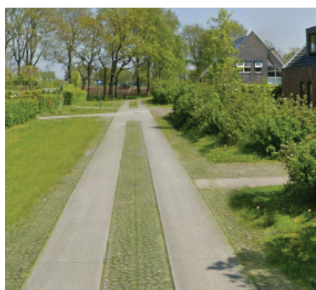
karrespoor, beton -Oude Tolweg Zuidlaren-
