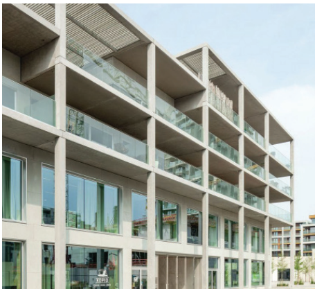
buitenruimte als onderdeel van de architectuur -Zuiderplein Antwerpen, -Atelier Kempe Thill-
