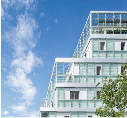
techniek opgenomen in de architectuur -Lot E8, Parijs, Avenir Cornejo Architects-
