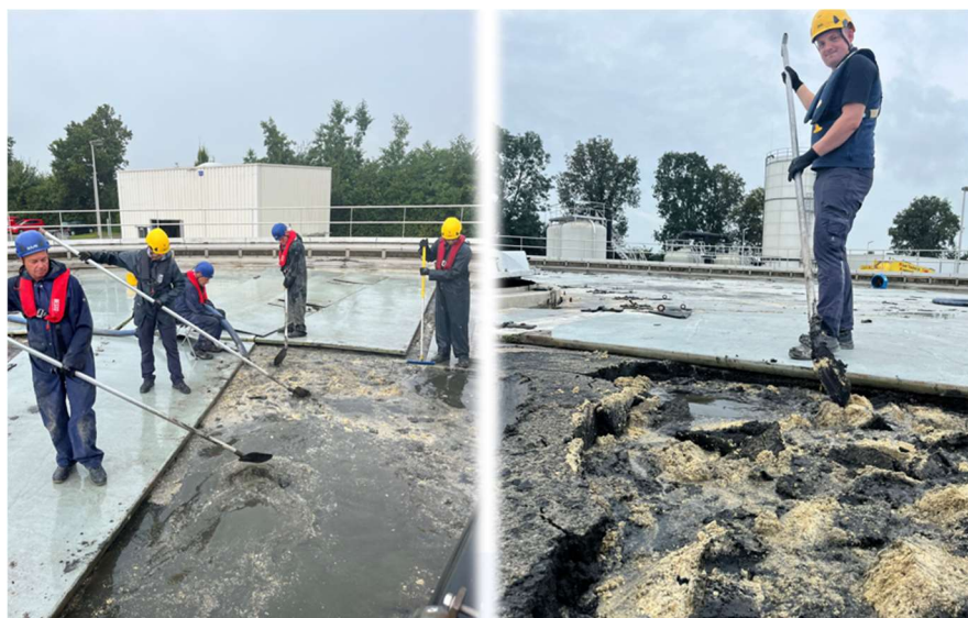
Figuur 29 Vetophoping voorbezinktank AWZI Tollebeek
