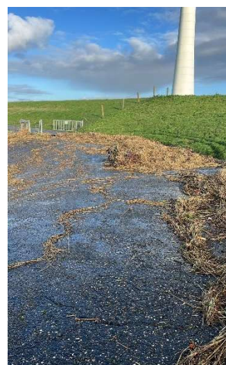
Figuur 12 Vloedmerk na storm op Westermeerdijk, november 2024
