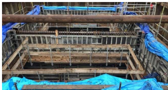
Figuur 30 Gemaal Nobelhorst in aanbouw in Almere
