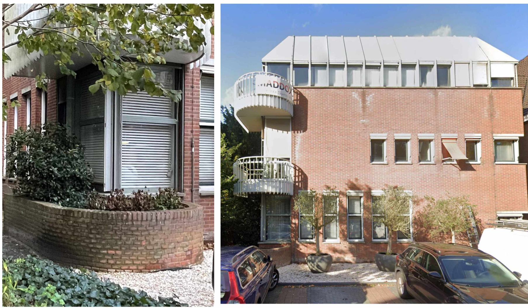
foto bestaande situatie
