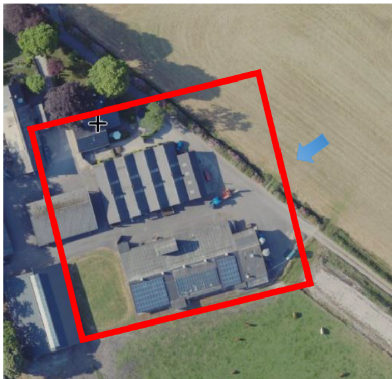
Figuur 2 Topografische ligging Oudedijk 15 te Uddel (bron: Street Smart) – slooplocatie
