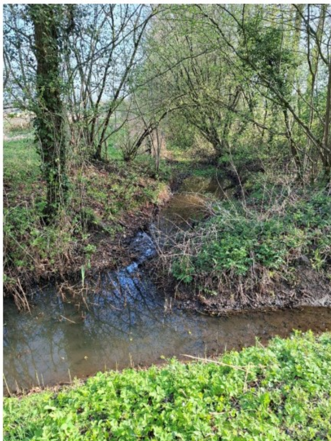
Figuur 5: Foto van het de ongedempte laatste 10 m van B-waterloop DO236 ter hoogte van de uitstroom in de bermsloot van de Svendonksestraat.
