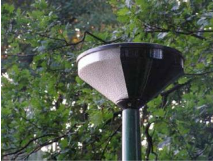
Voorbeeld afgeschermd verlichting
