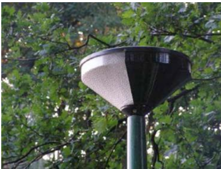
Voorbeeld afgeschermd verlichting
