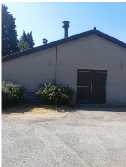
Figuur 4.1.6. Gebouw I.
