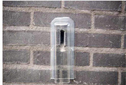
Figuur 8.3 Voorbeeld ongeschikt maken woning door exclusion flap over open stootvoeg.
