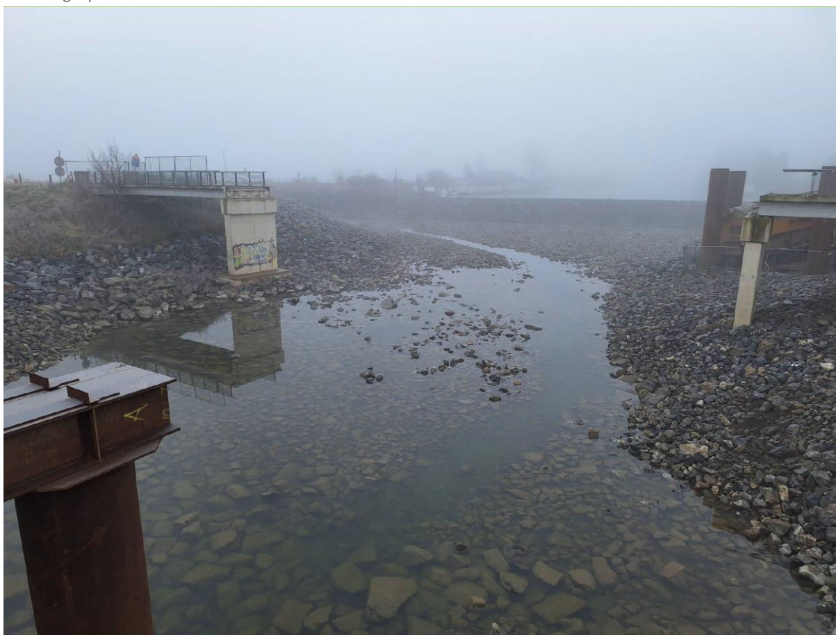
Figuur 1 Foto huidige situatie
