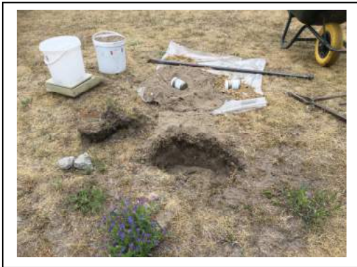
Gat 02 met links van het gat stukken van de tegelvloer.
