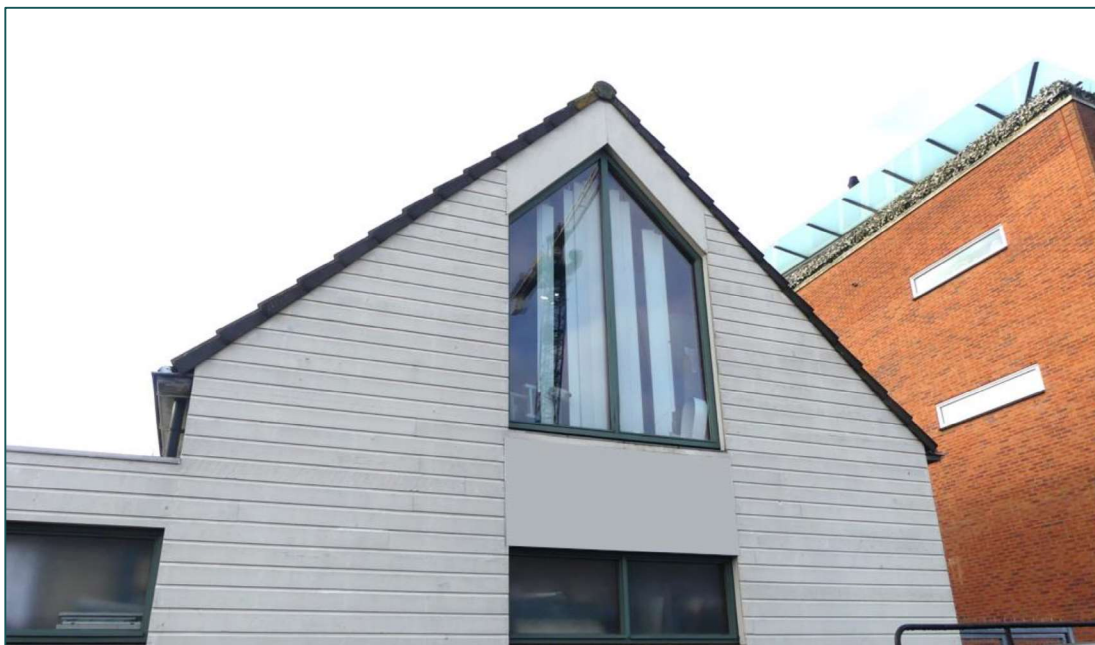
Figuur 1 Aan de planlocatie grenzende bebouwing betreft onder andere dit met pannen bedekt zadeldak, welke toegang bieden tot de dakruimte voor gierzwaluw en vleermuis.
