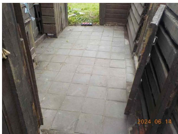
F13: Overzicht vloer.
