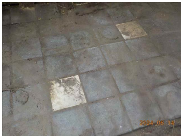
F10: Overzicht vloer.
