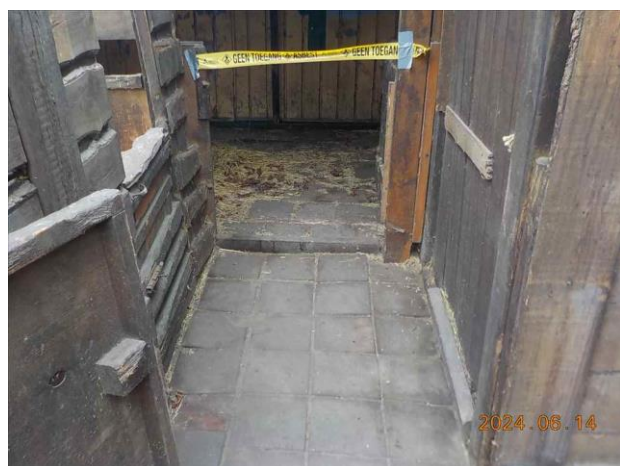
F12: Overzicht vloer.
