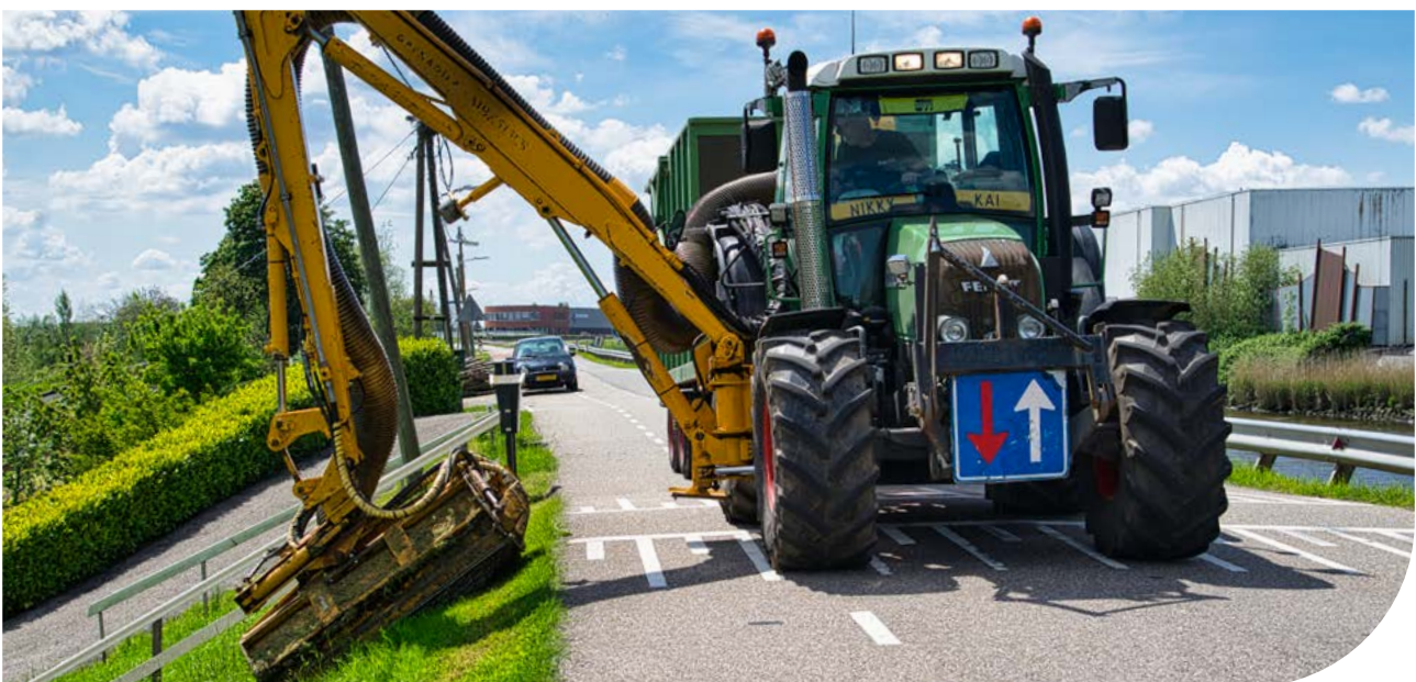
Afbeelding: Onderhoud van de dijk
