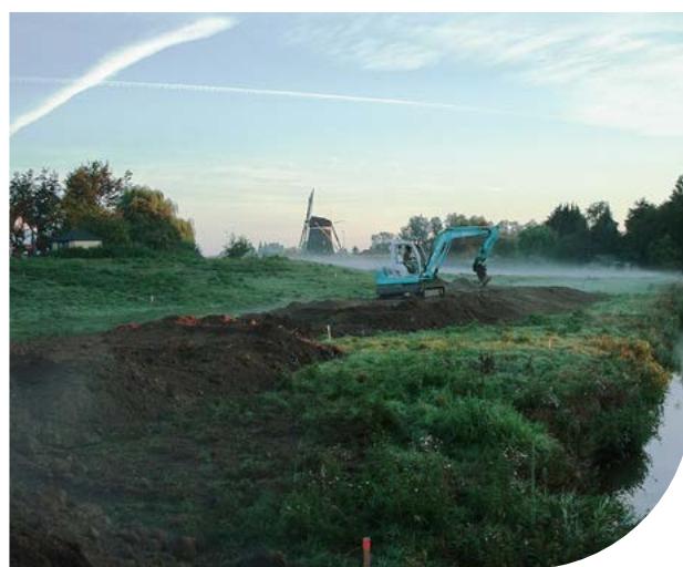
Afbeelding: Het versterken van een regionale waterkering
