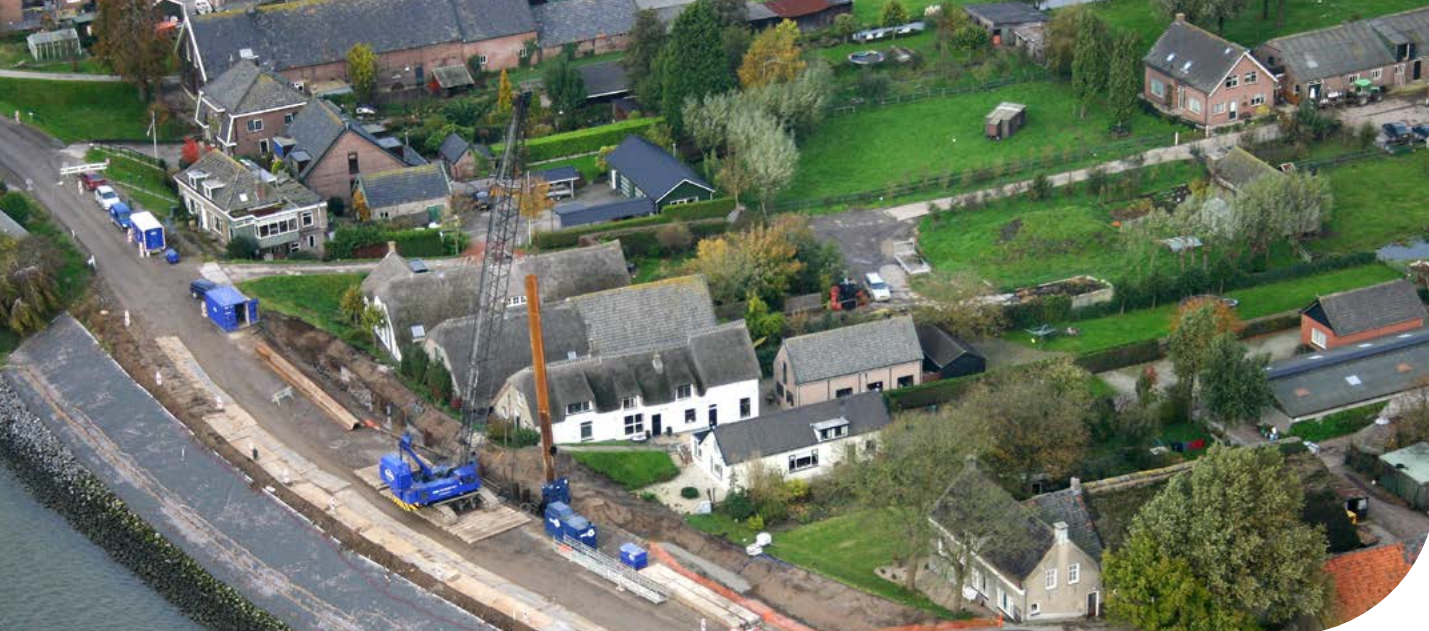
Afbeelding: Een dijkversterking in uitvoering
