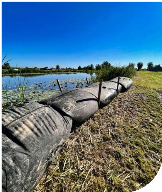
Afbeelding: De inzet van SlamDams als noodmaatregel tegen het overstromen van een regionale waterkering.
