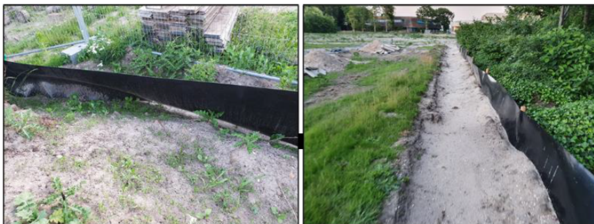
Figuur 3 Een incorrect geplaatst worteldoekscherm (links). Een correct geplaatst amfibiescherm (rechts). Deze dienen minimaal 10 cm ingegraven te zijn (bron foto's: Blom Ecologie).
