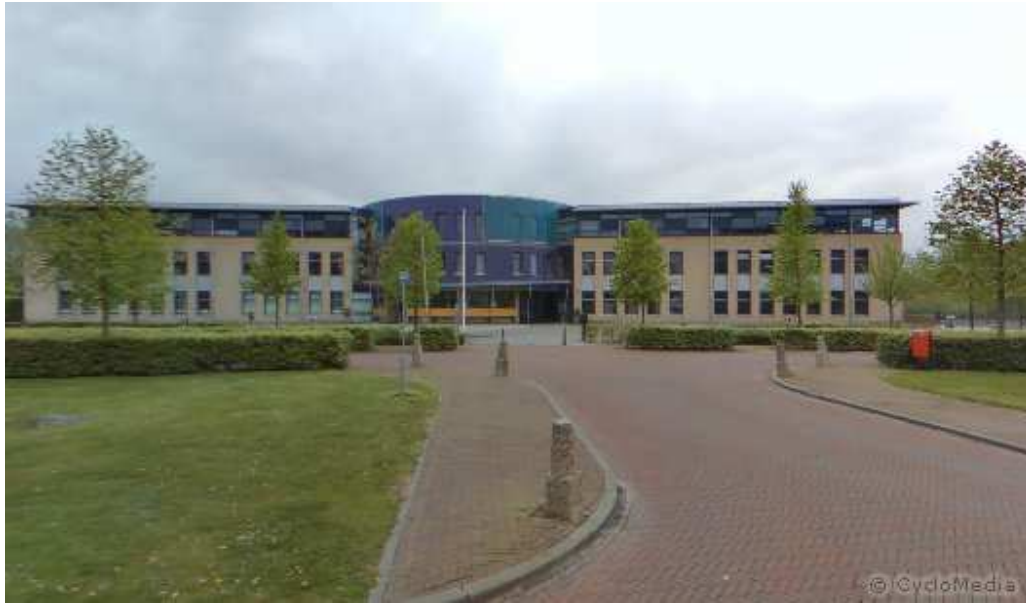
Figuur 2 Voorzijde huidige gebouw
