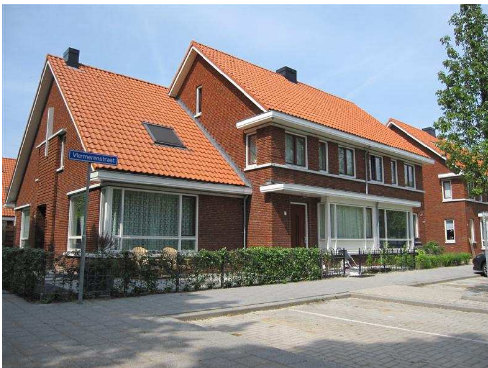
Figuur 4 Kleuraanduiding gevelsteen en dakpan.
