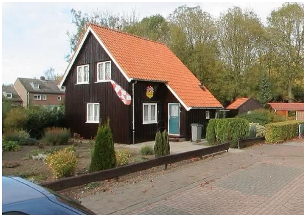
Figuur 4 Noorse woning aan 't Noorseplein in Klundert
