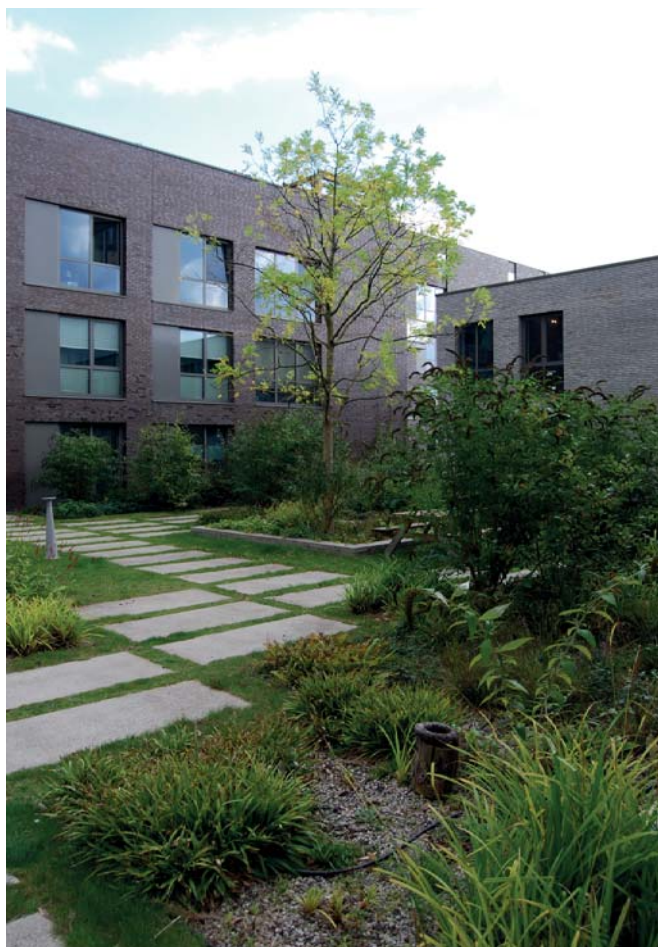
▲ Fig. 3.23 Referentie groen dak met dikkere substraatlaag (gebruiks- en biodiversiteitsdak) (Space-S, Inbo + Urhahn).
