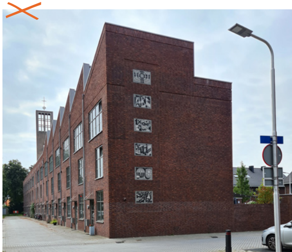
niet: blinde kopgevel
