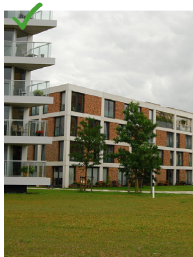
wel: groen tot aan de gevel
