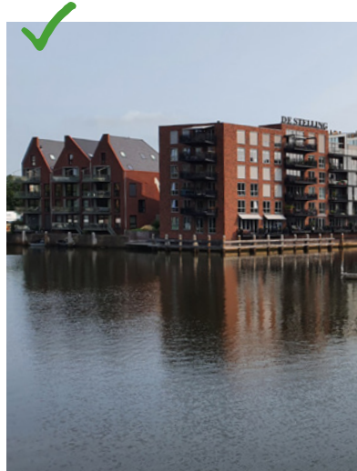
wel: variatie in daklandschap, hoofdmateriaal baksteen
