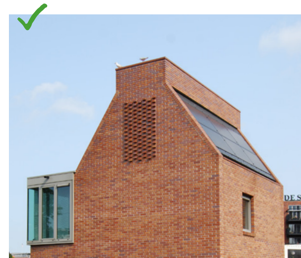
wel: geïntegreerde zonnepanelen op een hellend dak
