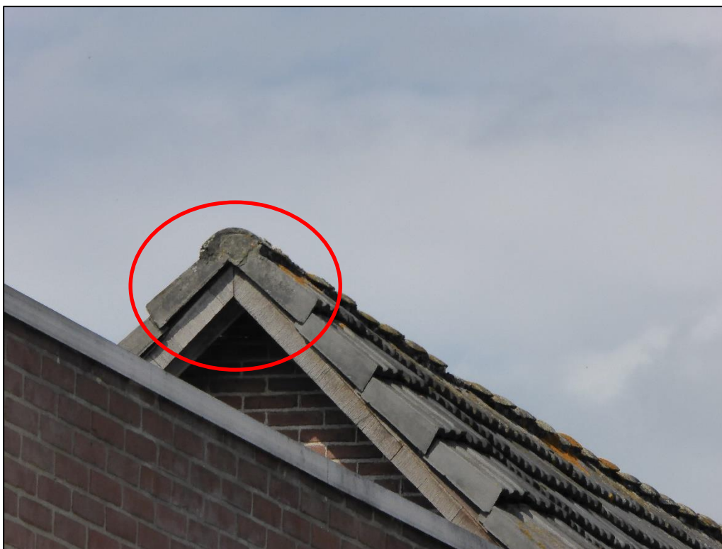
Ruimte aanwezig onder de nokpan, waar de gierzwaluw tot broeden kan komen.
