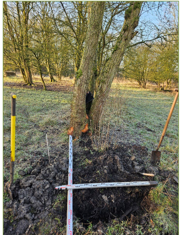
Zicht op sleuf nabij boom 16.
