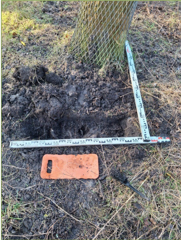
Zicht op sleuf nabij boom 24.
