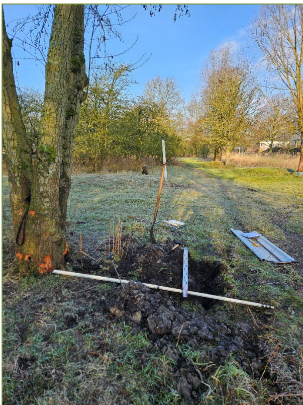
Zicht op sleuf nabij boom 16.
