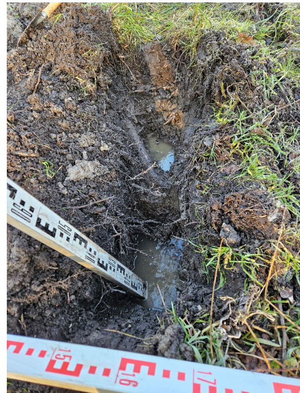
Zicht op sleuf nabij boom 16.
