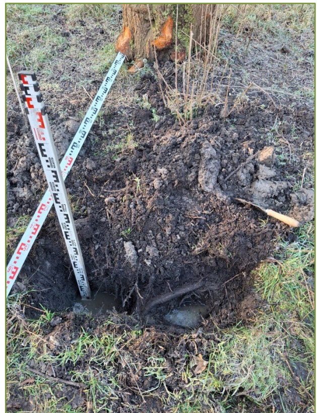
Figuur 5: Grondwater op 30 cm onder maaiveld in proefsleuf nabij boom 16.
