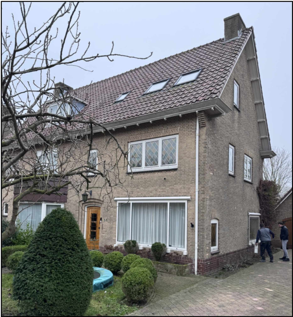
impressie bestaande situatie
