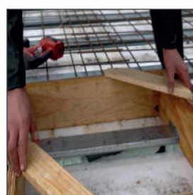
Bekisting / wapening plaatsen
