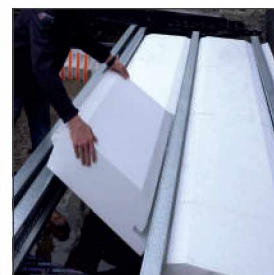
EPS broodjes plaatsen
