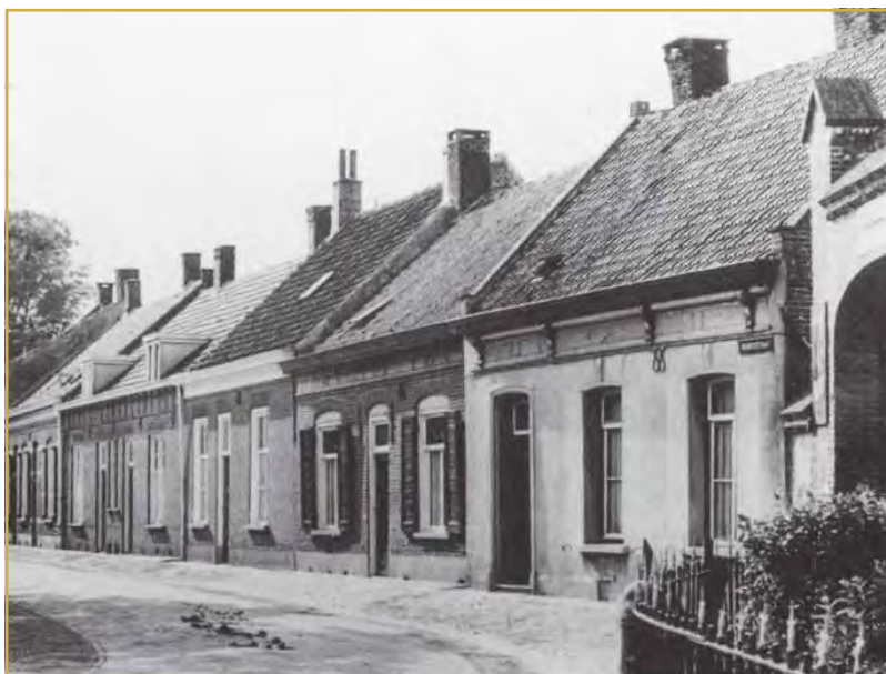
Gevelwand Wouwerstraat onderbroken door aanleg St. Sebastiaanstraat
