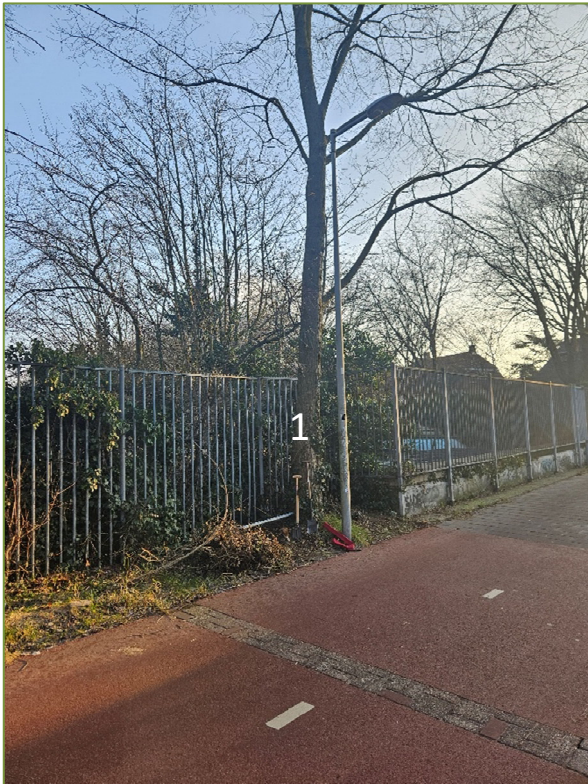
Figuur 10: Overzichtsfoto ter hoogte van boom 1 op de hoek van de fietsoversteek. De oversteek van een leiding is hier goed te zien.
