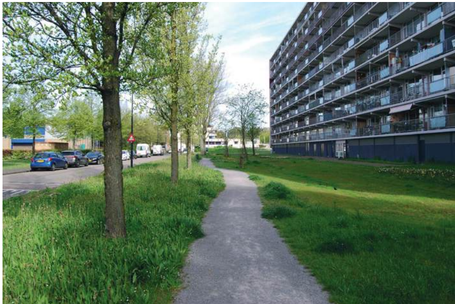
Fig 55. Recent aangelegde wadi in de Haydnlaan
