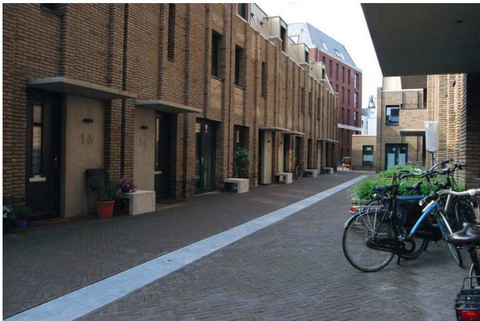
Fig 49. Autovrije straat, Kraanbolwerk Zwolle
